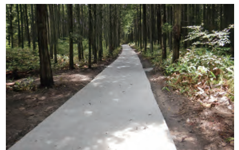
竹野山作業道コンクリート舗装
